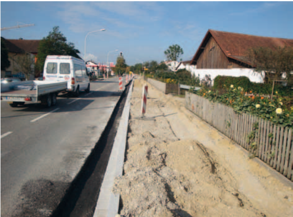
Der Fuß- und Radfahrerweg entlang der „alten B11“ wurde verbreitert.
