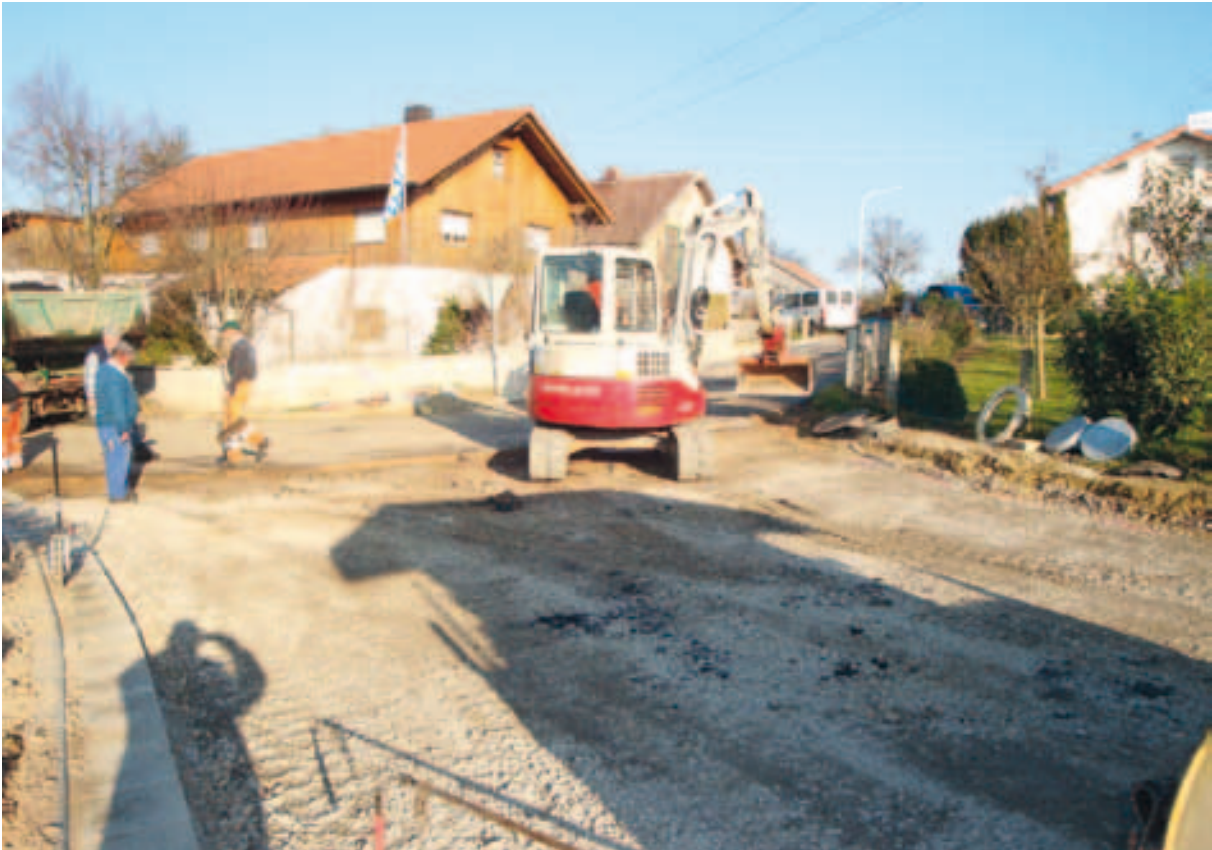
Die Kanalbauarbeiten in Kleinpilberskofen im Bereich der Bruckthaler Straße.
