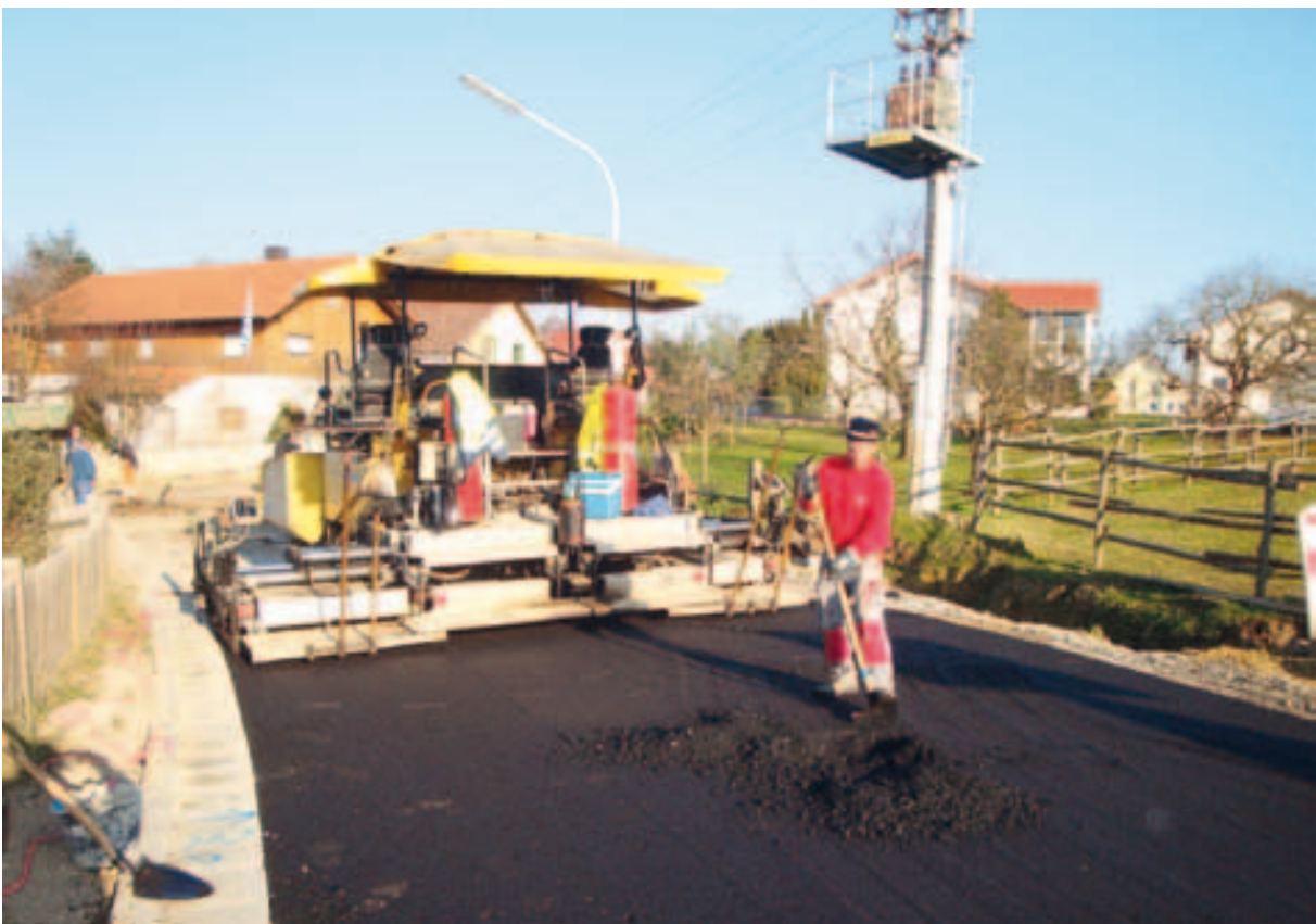
Die Ortschaften Kleinpilberskofen und Hackerskofen erhalten zum Abschluss der Maßnahme eine neue Asphaltdecke.
