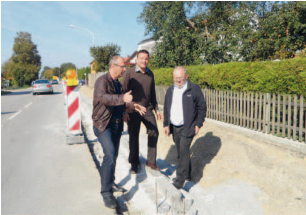
Baustellenbesprechung im Bereich der St. 2074 („alte B11“).
