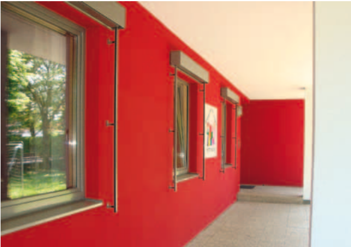
Der im Rahmen der energetischen Sanierung neu gestaltete Eingangsbereich des Kindergartens St. Stephan.
