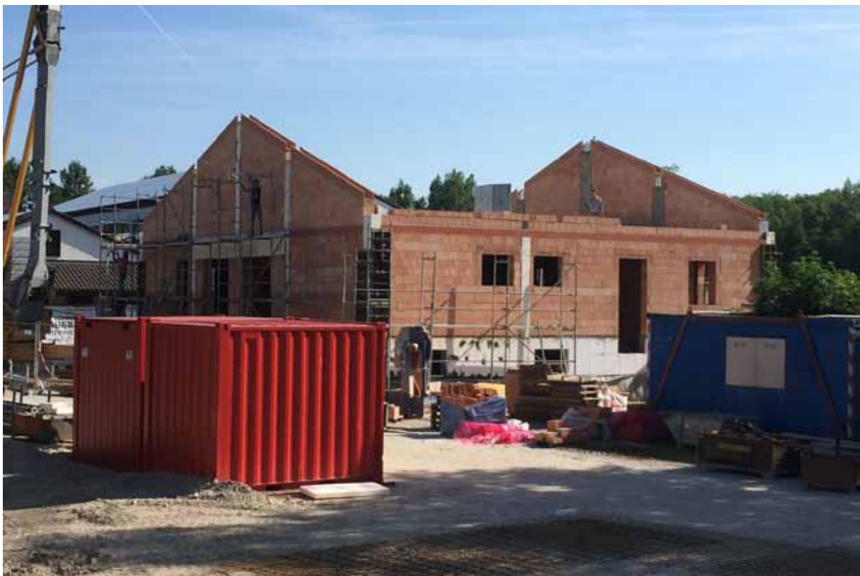
Der Rohbau des FC Sportheims.
