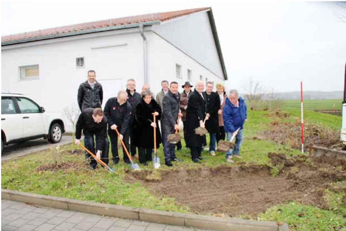
Spatenstich zur Erweiterung des Netto-Verbrauchermarktes.
