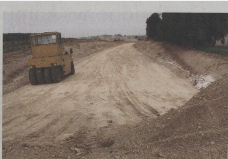
Bei Oberweilnbach ist die Ortsumfahrung schon komplett ausgehoben. Derzeit wird der Grund befestigt. Die Trasse wird erheblich unterhalb des Bodenniveaus verlaufen, so dass vom Verkehr keine Lärmbelästigung ausgeht. Insgesamt werden 180 000 Kubikmeter Erdreich abgetragen
