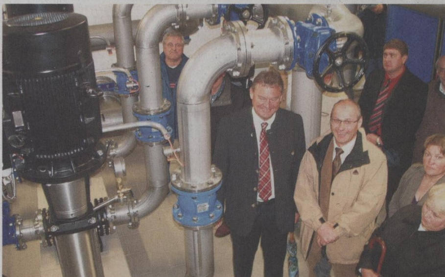
Das Herzstück des neuen Pumpwerks in Daibersdorf wurde besichtigt.
