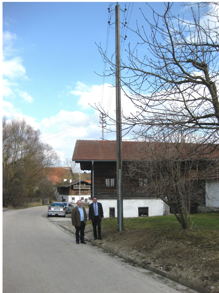
In Hackerskofen werden die Oberleitung abgebaut – Bürgermeister Gerald Rost und Schmidbauer waren vor Ort
