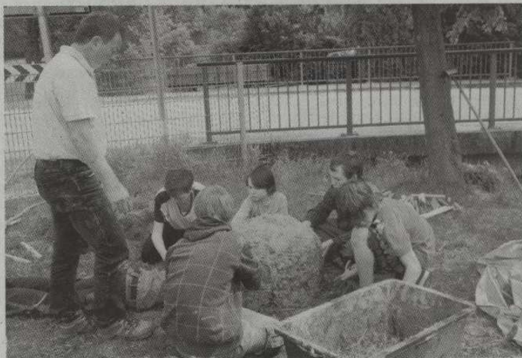
Die Wände werden unter Anleitung von Dr. Kreiner errichtet.
