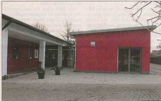
Auch architektonisch gelungen: Das Krippengebäude.
