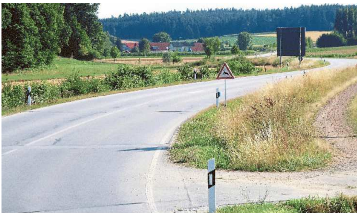
Der unbefestigte Anwandweg zwischen Frichlkofen und Oberweilnbach wird zum Radweg ausgebaut.
