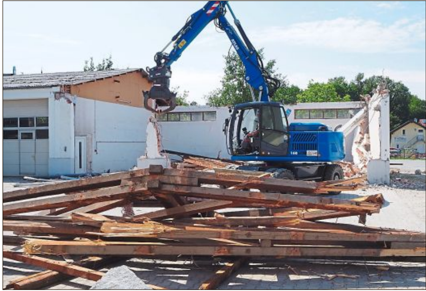
Der Teilabbruch des Bauhofs ist bereits erfolgt.
