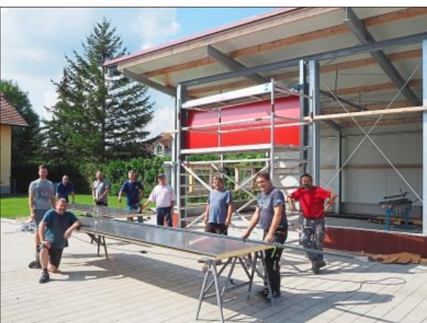
Die Helfer bringen derzeit die Sandwich-Platten an.
