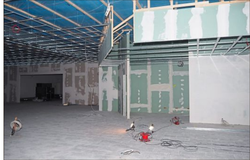
Hier entsteht die Imbiss- und Gebäcktheke.
