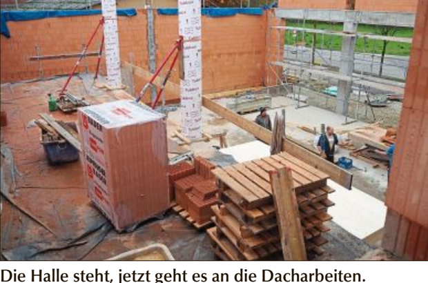
Die Halle steht, jetzt geht es an die Dacharbeiten.
