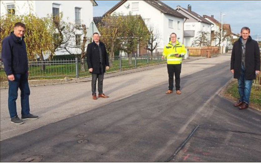
Die Sanierungsmaßnahme in der Gottfriedingerschwaige ist fertiggestellt, bei der Bauabnahme wurde gute Arbeit bestätigt.
