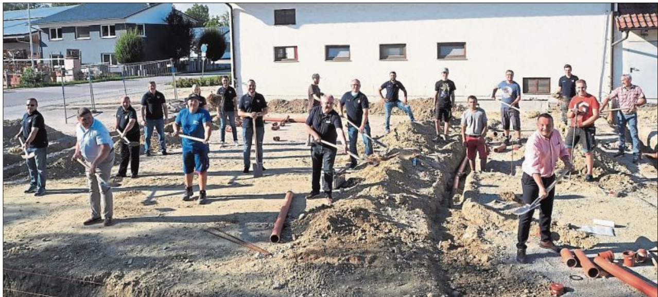
Der Spatenstich bei der Feuerwehr Gottfrieding war gemacht, der Bau geht aktuell gut voran.
