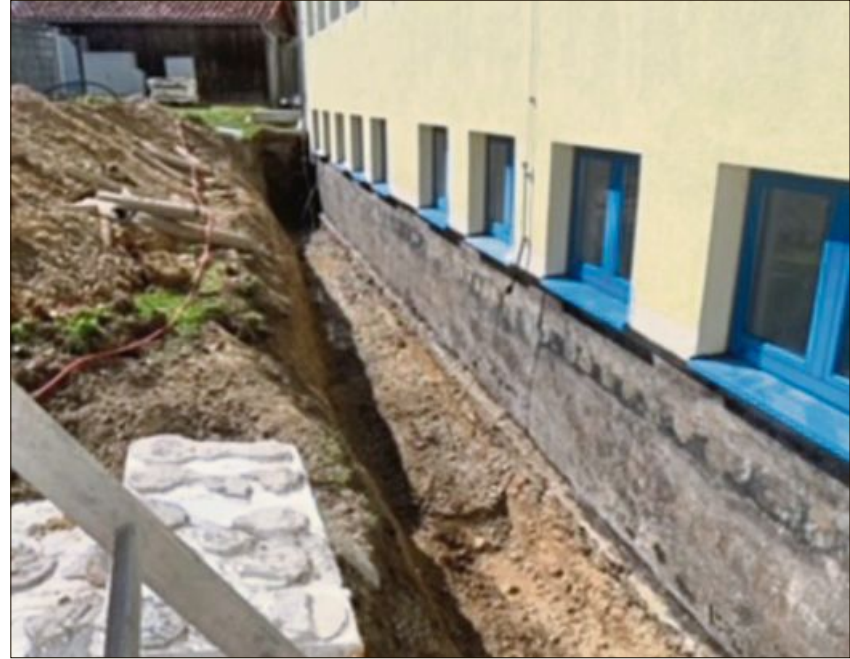
Reparaturmaßnahmen an der Schule sichern die Substanz.
