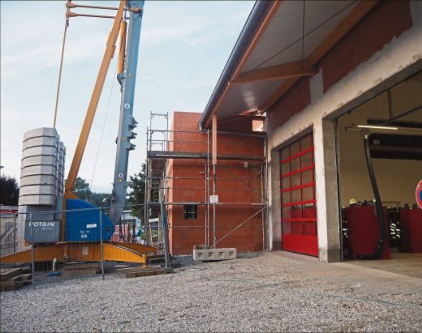
Die Arbeiten am Feuerwehrgerätehaus in Gottfrieding gehen gut voran.
