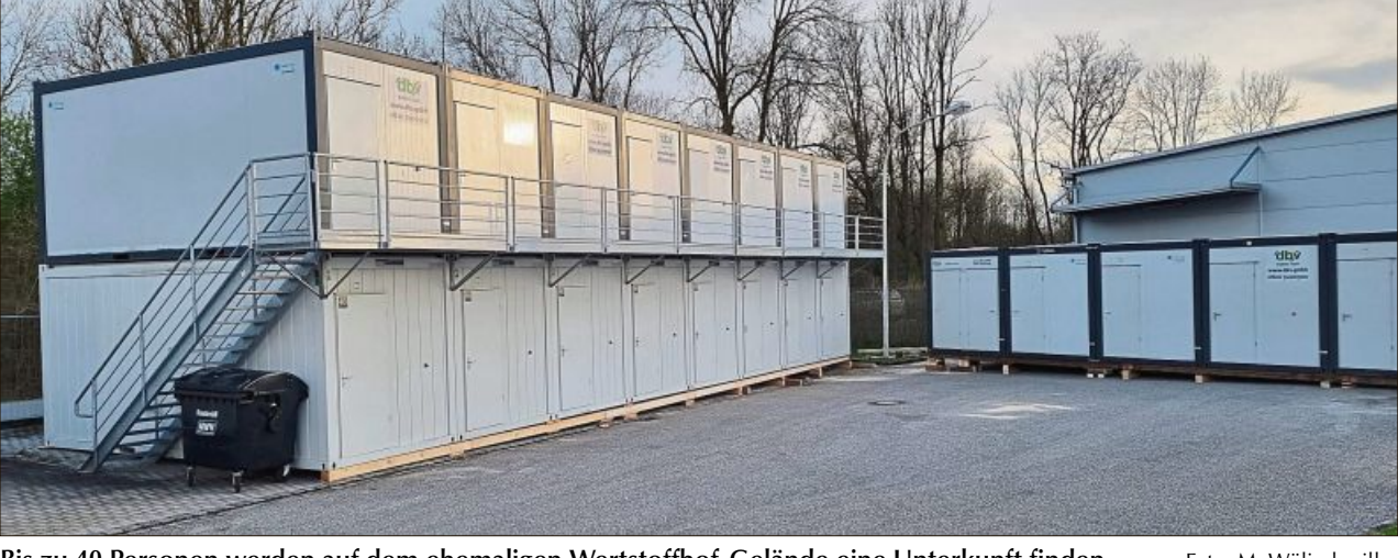
Bis zu 40 Personen werden auf dem ehemaligen Wertstoffhof-Gelände eine Unterkunft finden.
