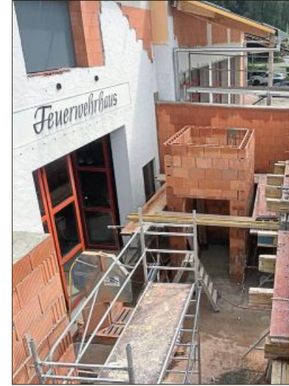
Der neue Eingangsbereich im Bau.
