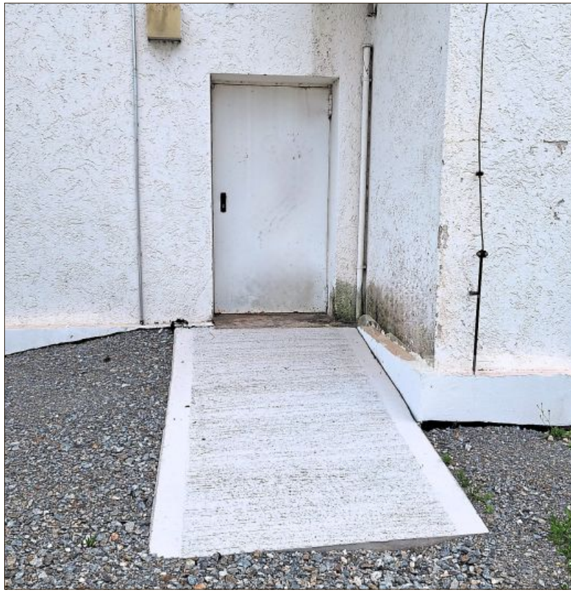
Der neu geschaffene barrierefreie Zugang zur Turnhalle.
